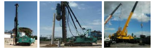
(จากซ้ายไปขวา) 1) บินจันสำหรับเจาะนำเสาเข็ม (Pre-bore), 2) บินจันคอกใส่ระบบไฮดรอลิก (Hydraulic Static Pile Driver), 3) รถกดเข็ม (Jack-in pile) Source: STECH
