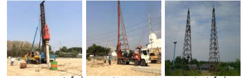
(จากซ้ายไปขวา) 1) บินจันล้อแทรค (Track-Mobile machine), 2) บินจันรถล้อยาง (Mobile machine), 3) บินจันโครง (Rig) Source: STECH
